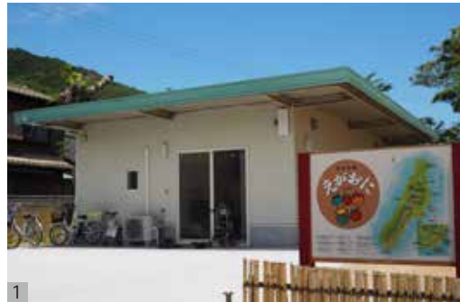
1 交流施設「女木の里」外観
